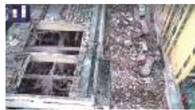
6月13日上午，湖北十堰市張灣區燃氣爆炸後造成巨大傷亡。（視頻截圖）
